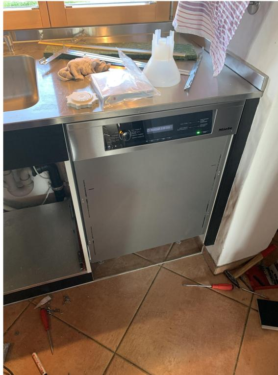
**Das Neugerät wird eingebaut und ausgerichtet. Die vorhandene Dekorfront kann wieder montiert werden. In unserem Beispiel wurde neu kein vollintegriertes Gerät mehr montiert, sondern eines mit Edelstahl-Blende.**
