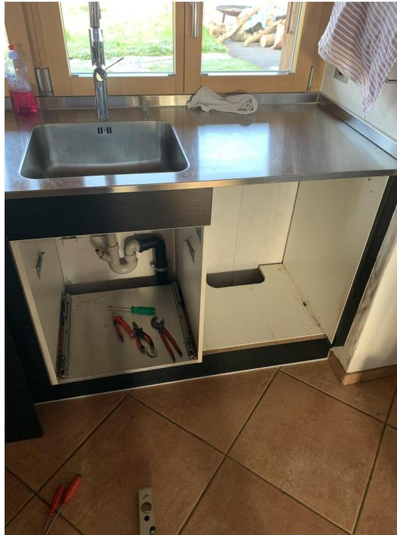
**Das Altgerät wird ausgebaut und die Nische ausgeräumt. Der Sockel wird ausgeschnitten und entfernt, die vordere Sockelblende gekürzt und angepasst.**
